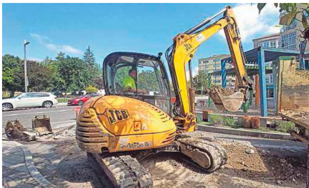
El final de la calle del Conde está cortado porque hubo que abrir un agujero en la calzada. c.c.
